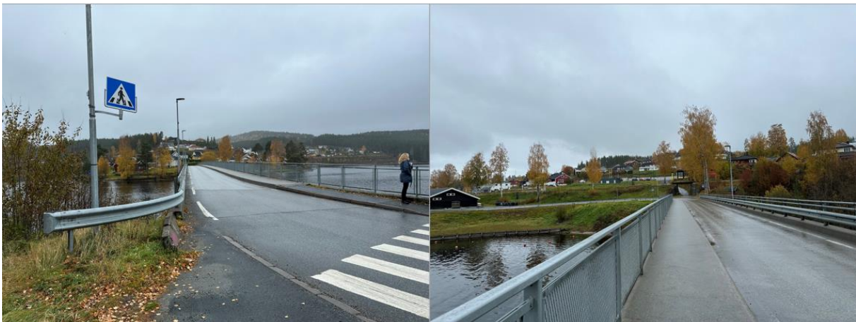
Figur 2.7: Til venstre: Gangfelt mellom brubakken og fortau langs Krøderen bru. Til høyre: smalt fortau langs Krøderen bru (foto: SØR arkitekter AS).
