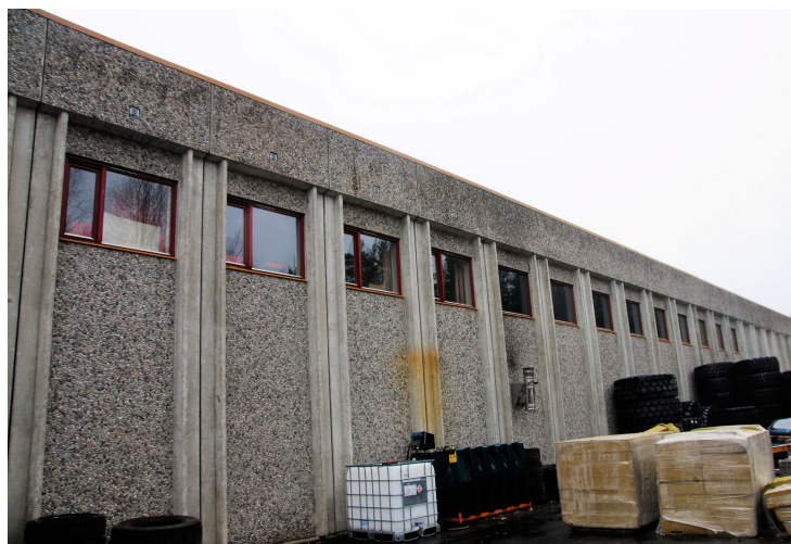
Figur 3 Fasade mot nord.
