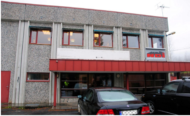
Figur 4 Fasade av kontordelen mot øst
