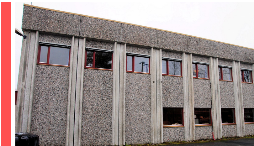
Figur 11 Isolérglassvinduer på 1985-bygget
