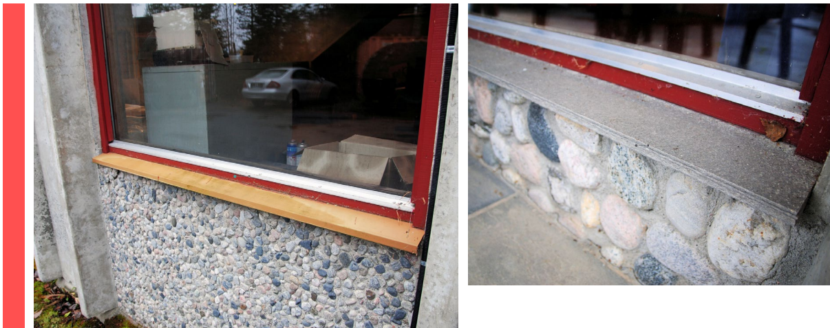
Figur 8 Nærbilder av vinduene i 1985-bygget.
