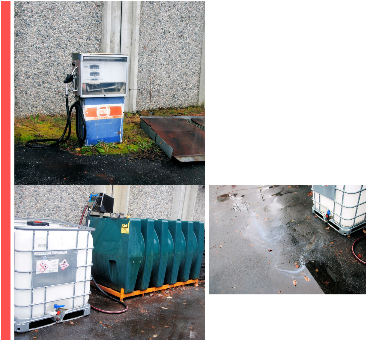
Figur 17 Øverst: Dieselpumpe fra 1975. Nederst: HX95-tanken, samt antydninger til søl av kjemi til høyre.
