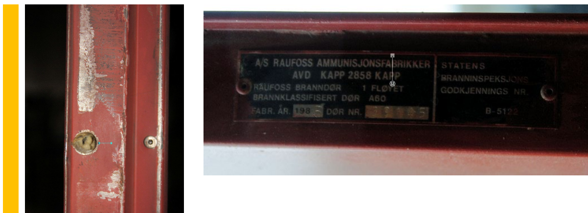
Figur 9 Branndør inneholder ikke asbest.
