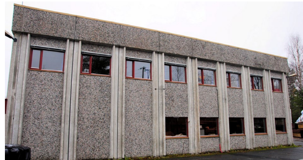
Figur 5 Fasade av kontordelen mot nord
