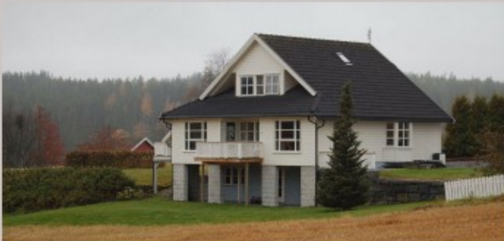
En skreddersydd løsning hvor tilbygget omkranser 3 av husets fasader. Det nye taket bryter med eksisterende takvinkel på en god måte. Sigdal Foto: I.J.J.
