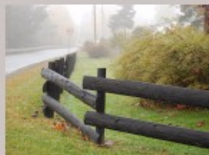
Ved å trekke gjerdet inn på eien- dommen kan det etableres en sone mot veien som lett kan klippes. Modum.
