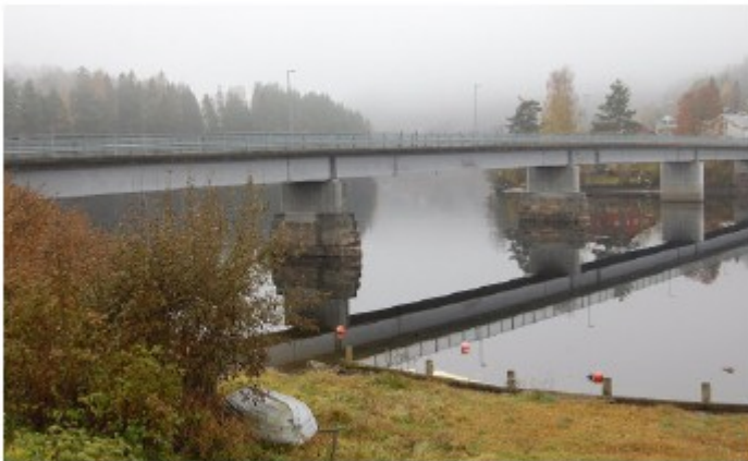
Bru over Krøderen. Opprinnelsen er usikker, men brua ble restaurert i 1986/87. Brua er ført opp på gamle konstruksjoner fra tidligere tider. Foto: I.J.J.
