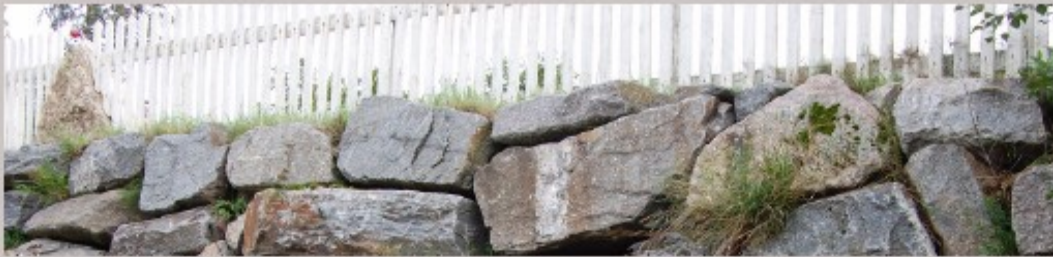
En fin stablesteinsmur med hvitt stakittgjerde på toppen. De grønne grastustene i sprekken gir liv til muren. Slike natursteinsmurer passer godt i tilknytning til eldre og større bebyggelse. Krødsherad Alle foto på siden: I.J.J.
