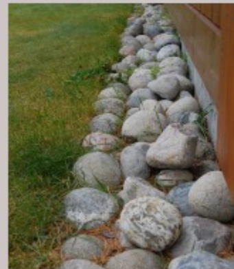
Rullestein som renne mot veggen er fint der det er vanskelig å få planter til å gro pga av tørke. Dekorativt er det også.
